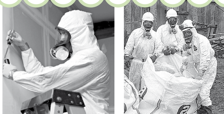
คนงานรื้อถอนวัสดุที่มีแร่ใยหินในอเมริกา
