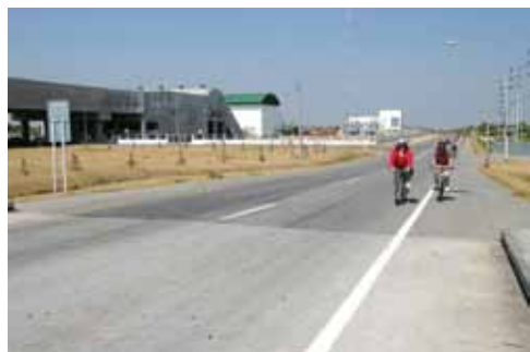
ซ้ายมือคือสะพานส่งน้ำขนาดมหึมา
