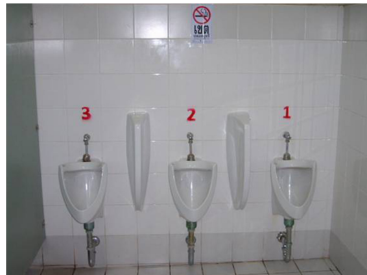
โรงเรียนดาราวิทยาลัย ติดสติ๊กเกอร์เขตปลอดบุหรี่ที่ห้องสุขา
